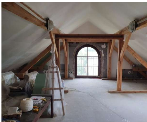
Půdní prostor - budoucí ateliér
