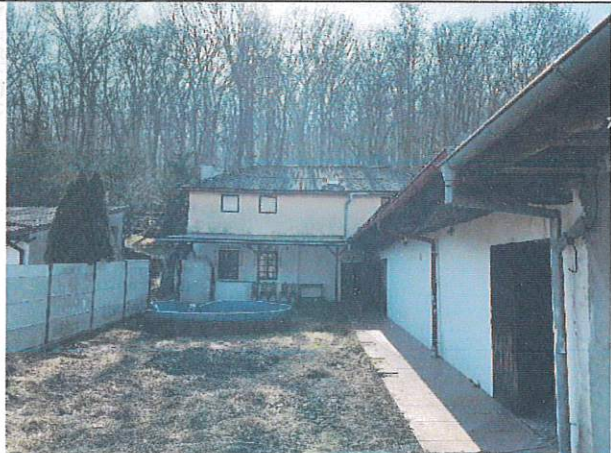
Pohled na dům ze dvora
